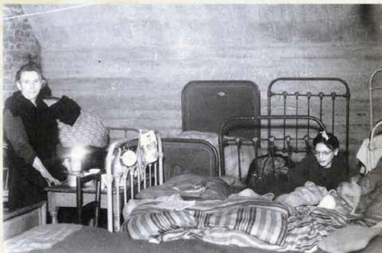
Aménagement des abris dans les caves
